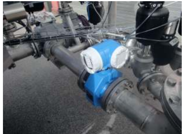
Durchflusskontrollierte Hochleistungs-Umwälzanlage Flow-meter controlled high-power circulation equipment
